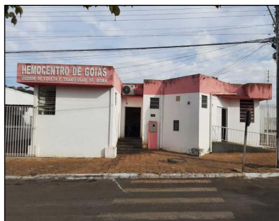
Imagem da estrutura da unidade de Iporá antes de início da reforma.
